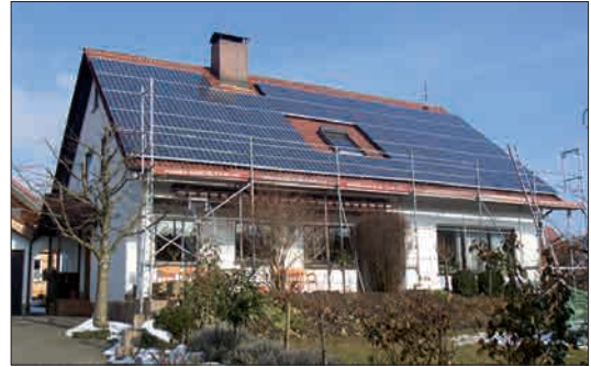
Hình 1: Hệ thống quang voltaic
