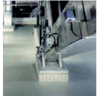
Hình 1: Nền của xưởng công nghiệp
